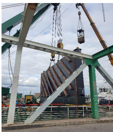
En septiembre se sustituyeron las compuertas de la esclusa sur.
