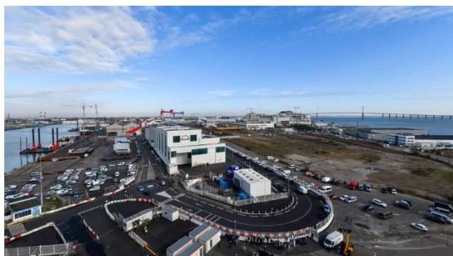
Ahora la calle de la Forme Joubert rodea la zona industrial de preensamblaje de los futuros aerogeneradores marinos.
