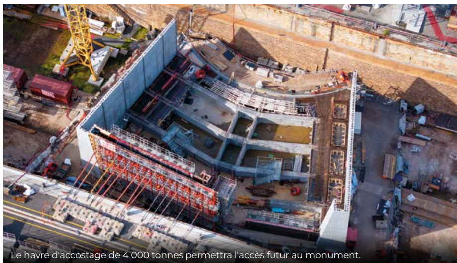
Les deux ouvrages de protection du Fort Boyard se construisent au cœur des infrastructures portuaires nazairiennes.
