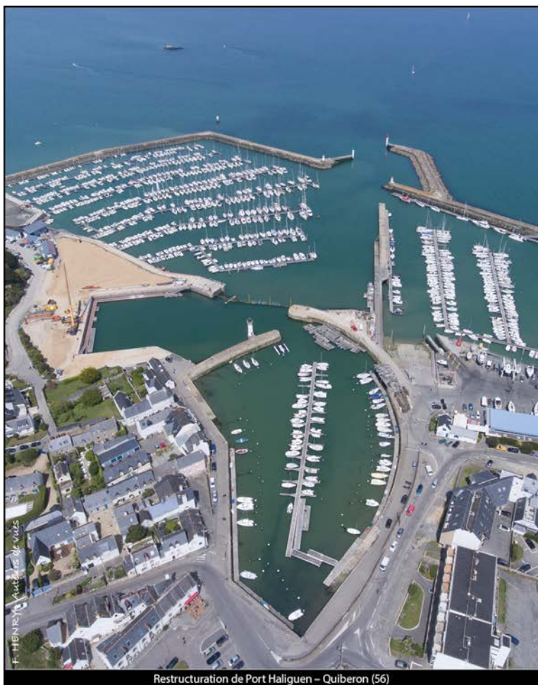
Restructuration de Port Haliguen - Quiberon (56)
