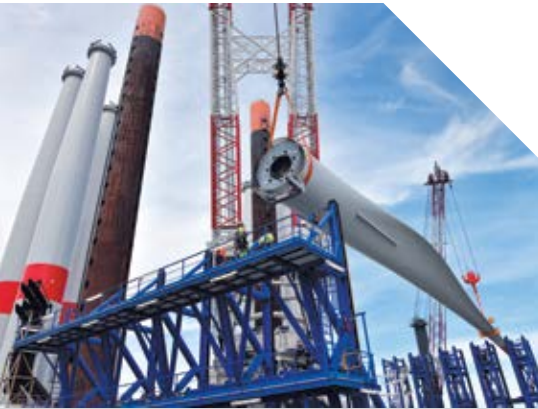
Carga de palas de aerogeneradores.
