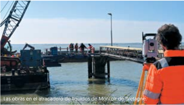
Las obras en el atracadero de líquidos de Montoir de Bretagne.
