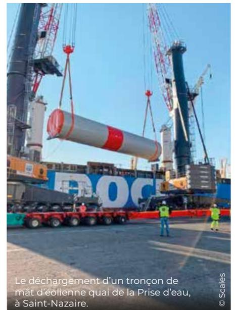
Le déchargement d'un tronçon de mât d'éolienne quai de la Prise d'eau, à Saint-Nazaire.
