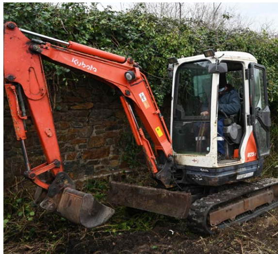
Lors de travaux menés par le pôle insertion au Pellerin.
