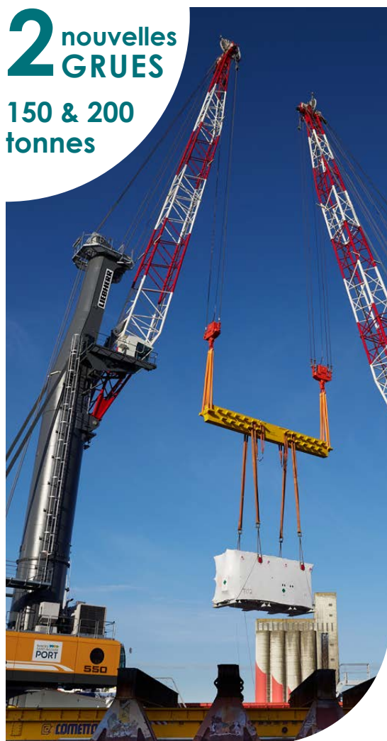
Le déchargement d'un colis industriel à Saint-Nazaire
