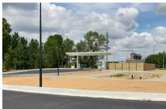
La station GNV de Montoir de Bretagne en cours de finalisation.
