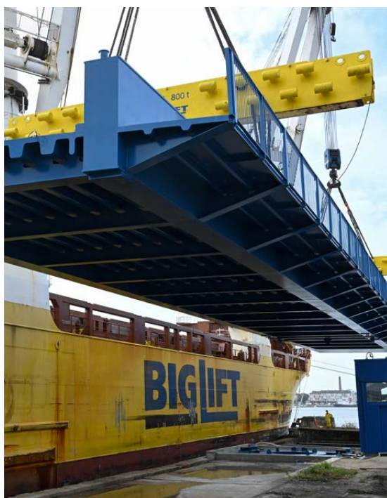
La mise en place du nouveau tablier du pont du Pertuis.
