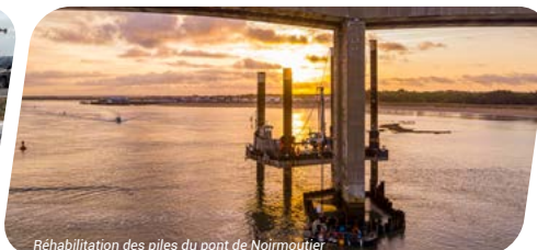
Réhabilitation des piles du pont de Noirmoutier
