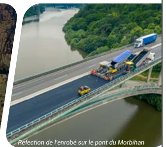
Réfection de l'enrobé sur le pont du Morbihan
