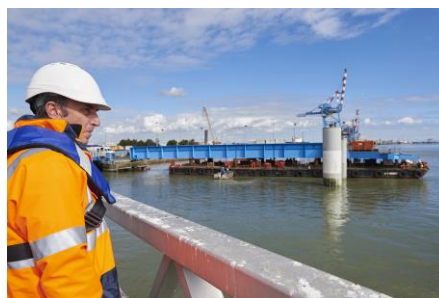
Sur le chantier du poste roulier n°3.
