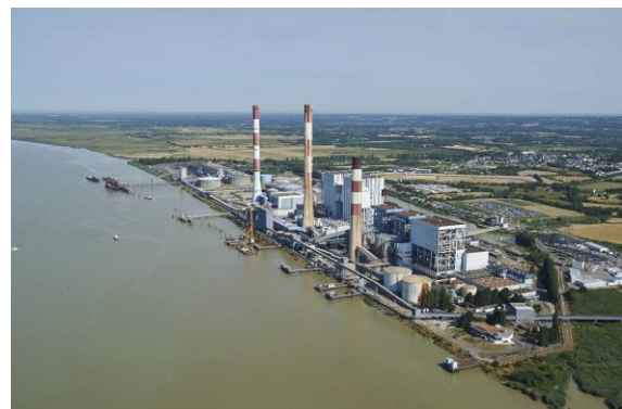
La centrale thermique EDF de Cordemais.
