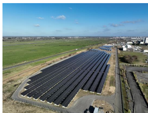
Au Nord et à l'Est du terminal méthanier, la centrale photovoltaïque exploitée par Engie Green.
