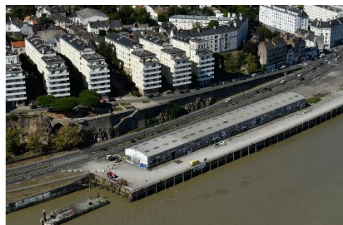
Le site du hangar 12, quai d'Aiguillon, fait l'objet d'un projet de valorisation.
