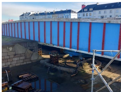
Chantier de rénovation du pont tournant de l'écluse sud de Saint-Nazaire.
