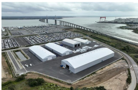
En deux ans, cinq bâtiments métallo-textiles ont été livrés sur le pôle industriel.
