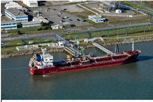
Le poste à liquides de Montoir de Bretagne.
