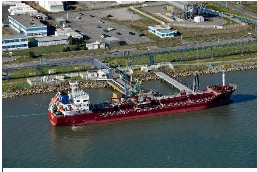
The Montoir de Bretagne liquid cargo berth.
