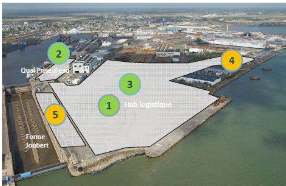
FIGURE 25 : TRAVAUX DU HUB LOGISTIQUE SOUS MAITRISE D'OUVRAGE DU GPMNSN (SOURCE : GPMNSN)
